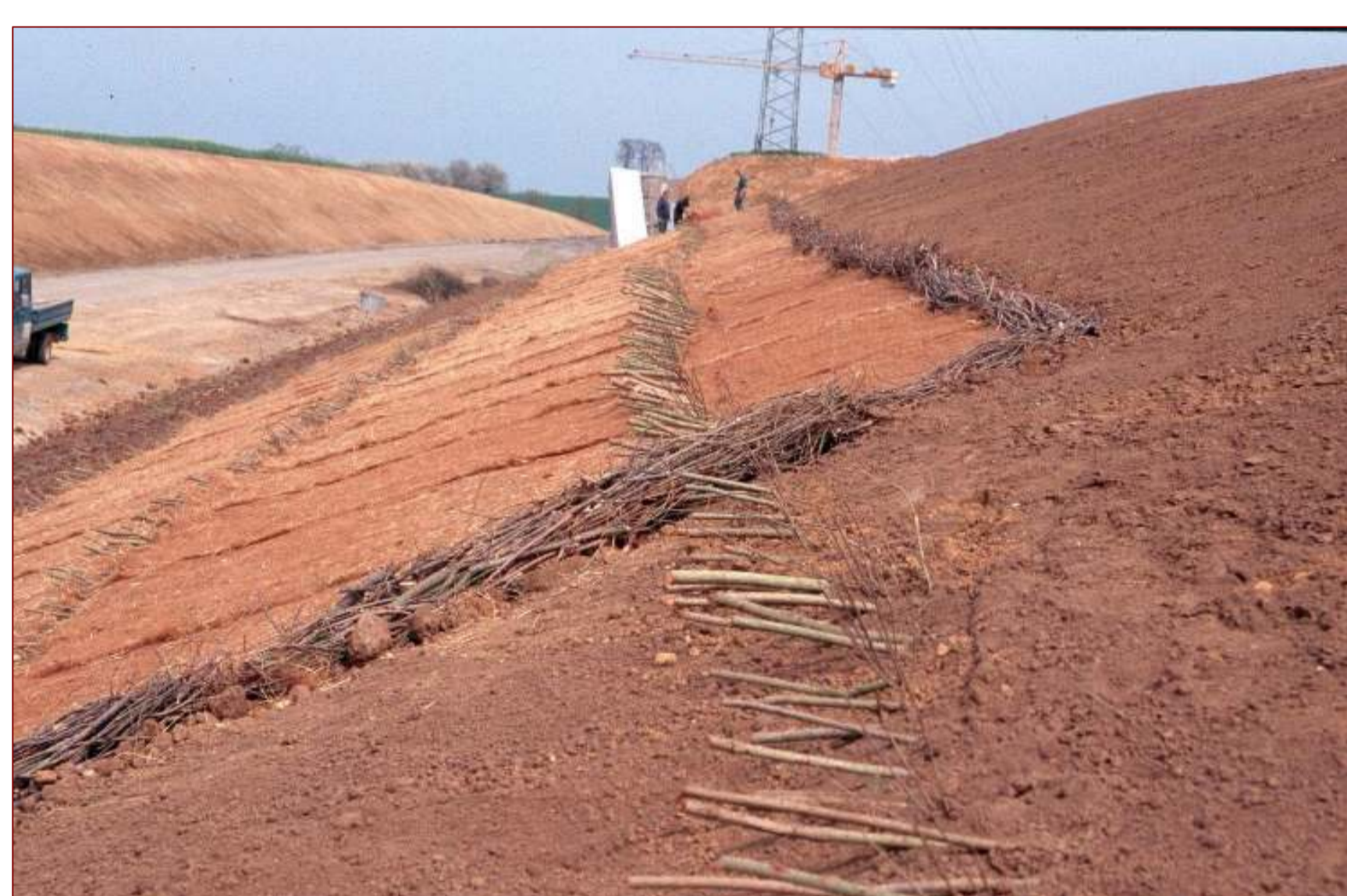
Erosionsschutz mit Faschinen (Reisigbündel) sowie Strohmaten, Anpflanzung von Knüppel-Weiden und Sträuchern
