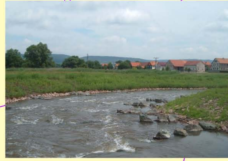
Beispiel für Querbauwerk mit Fischaufstiegsanlage: Werra, Umgehungsgerinne Sallmannshausen
