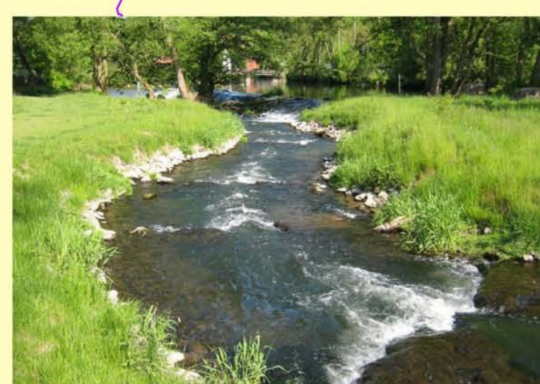
Beispiel für Querbauwerk mit Fischaufstiegsanlage: Werra, Umgehungsgerinne am Brückenmühlwehr in Vachdorf
