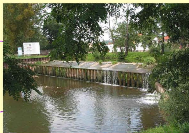
Beispiel für Querbauwerk als Wanderhindernis: Werra, Wehr in Tiefenort
