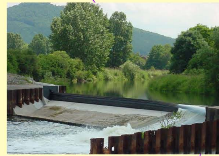
Beispiel für Querbauwerk als Wanderhindernis: Werra, Wehr in Dorndorf
