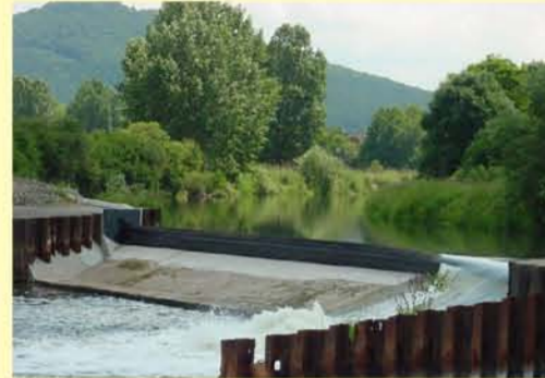
Werra, Wehr in Dorndorf Querbauwerk als Wanderhindernis
