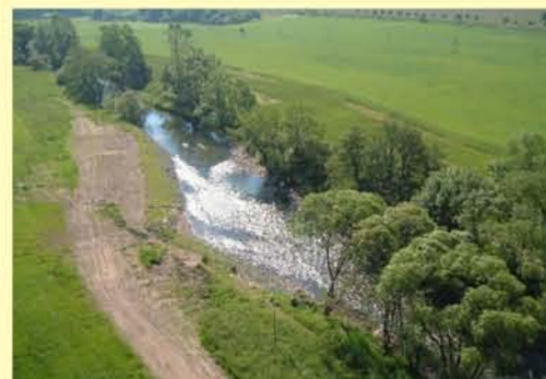
Beispiel für durchgängiges Querbauwerk Werra, Sohlgleite am ehemaligen Wehr Gasturbinenwerk Einhausen
