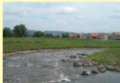
Beispiel für Querbauwerk mit Fischabstiegsanlage Werra, Umgehungerinne Sallmannshausen
