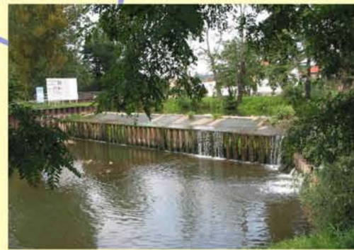
Werra, Wehr in Tiefenort Querbauwerk als Wanderhindernis
