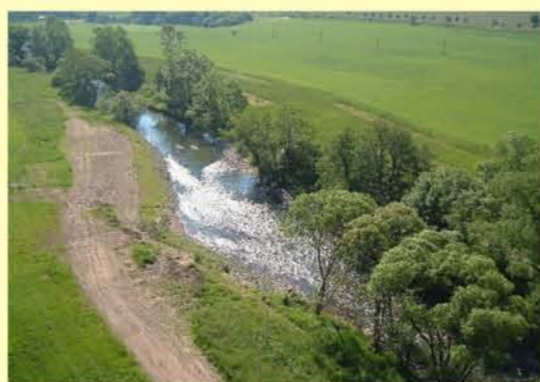
Beispiel für durchgängiges Querbauwerk: Werra, Sohngleite am ehemaligen Wehr Gasturbinenwerk Einhausen
