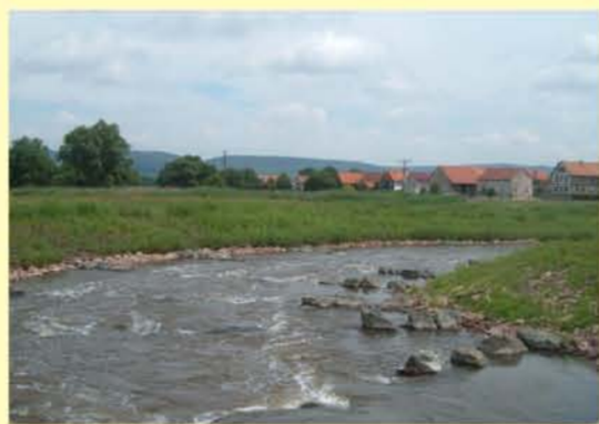
Werra, Umgehungsgerinne Sallmannshausen, Querbauwerk mit Fischauflastanlage
