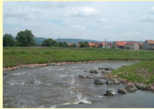
Werra, Umgehungsgerinne Salmannshausen, Querbauwerk mit Fischaufstiegsanlage
