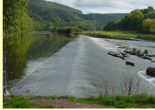
Werra, Wehr in Falken, Querbauwerk als Wanderhindernis
