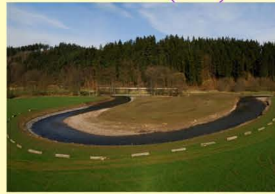
Schleuse, neue Gewässerschleife Zollbrück Foto: Peter Seidel
