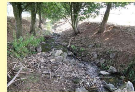
Bach aus Oepferhausen, ausgebautes Gewässer mit landwirtschaftlicher Nutzung
