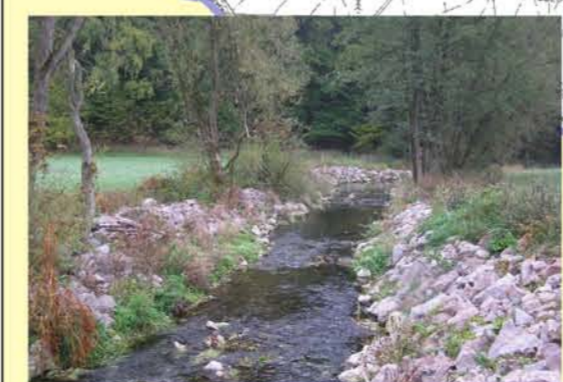
Beispiel für den Umbau eines Wehres in eine Gleite: Effelder oh. Döhlau, Ersatz eines ehemaligen Bewässerungswehres durch eine flache Sohlengleite
