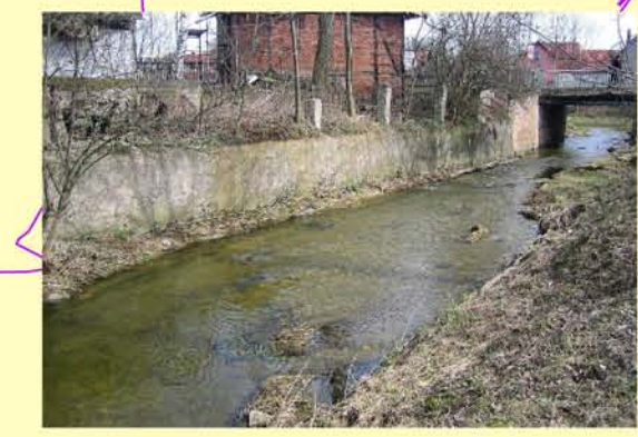
Urbach bei Ebeleben, Ufermauer Foto: THLG
