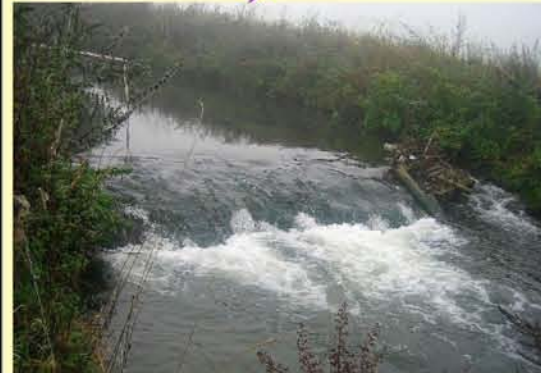
Orla, Absturz bei Langenorla
