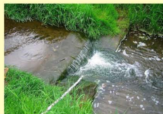
Steinbach, Bodenrode, Absturz, einfach rückbaubar
