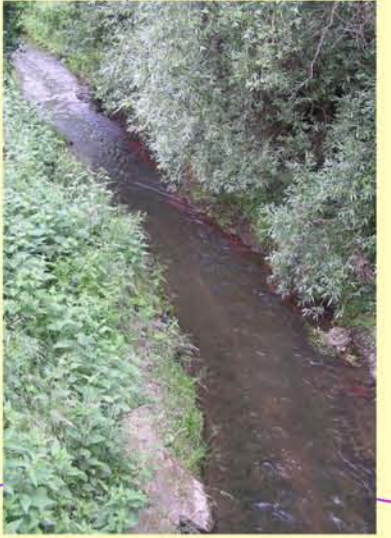
Herressener Bach, begradigt und mit Pflaster befestigter Abschnitt
