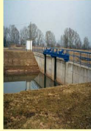
Helme Einlauf HWRB Kelbra Abschlagbauwerk, nicht durchgängig Foto: IB Meinecke
