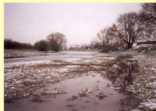
Zorge, Nordhausen Steinmühlweg typisches Defizit - Uferverbau
