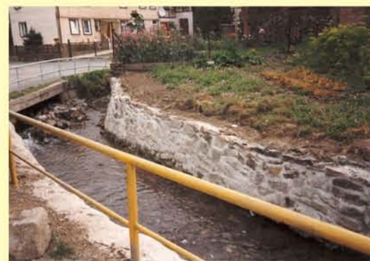
Sülze, Werna beidseitige Ufermauer
