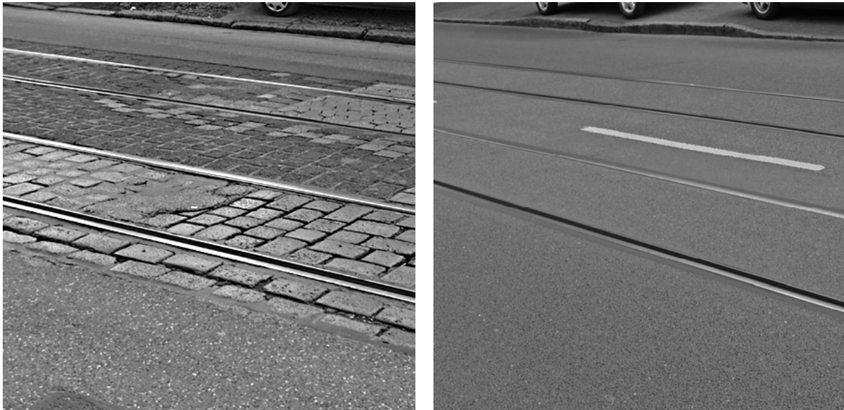
Abbildung 15: Fahrbahnoberfläche vor und nach der Erneuerung
